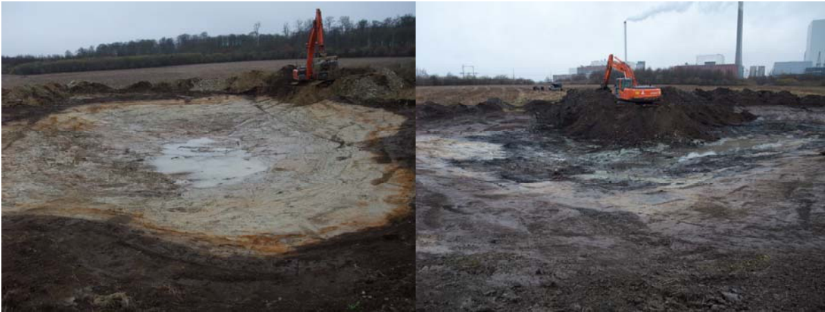
Vandhul 6 (venstre og 7 (højre) under gravning.
