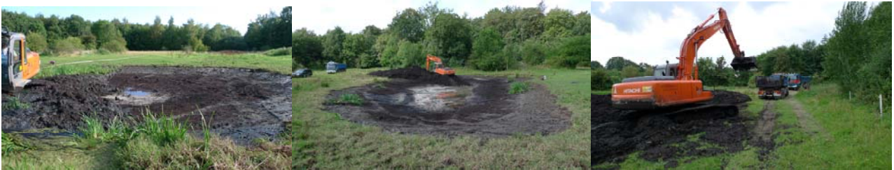
Vandhul 4 under oprensning. Opgravet materiale er fjernet fra eng med lastbil og kørt til dyrket mark ved Skibhusvej.
