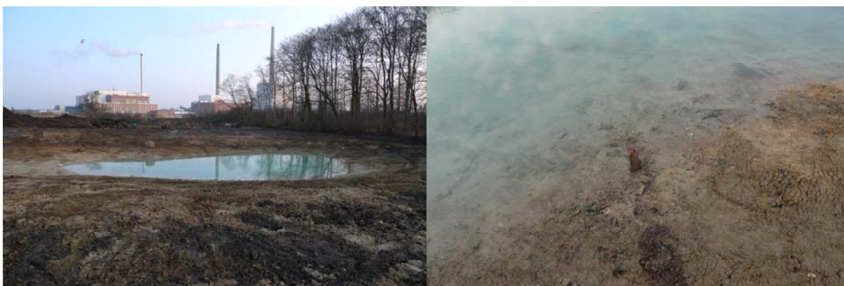
Vandhul 9 kort efter gravning (venstre). To tilløb af dræn blev fundet og lagt rundt om vandhullet (højre).
