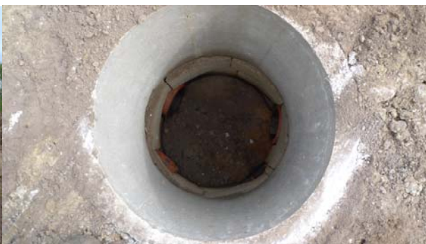
Vandhul 11 under gravning (venstre) og ny drænbrønd med tre omlagte drænrør (højre).
