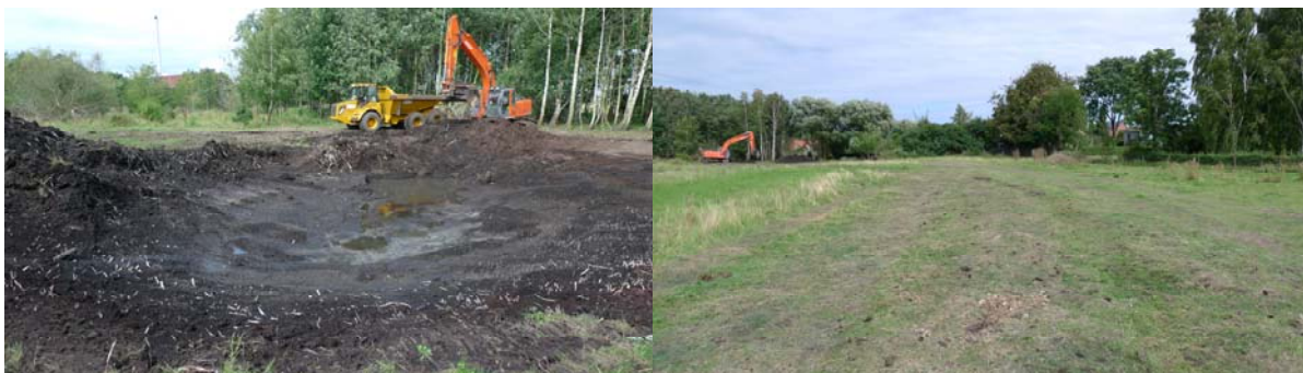
Det opgravede materiale er kørt med dumper over engen til dyrket mark uden væsentlige skader på vegetationen.
