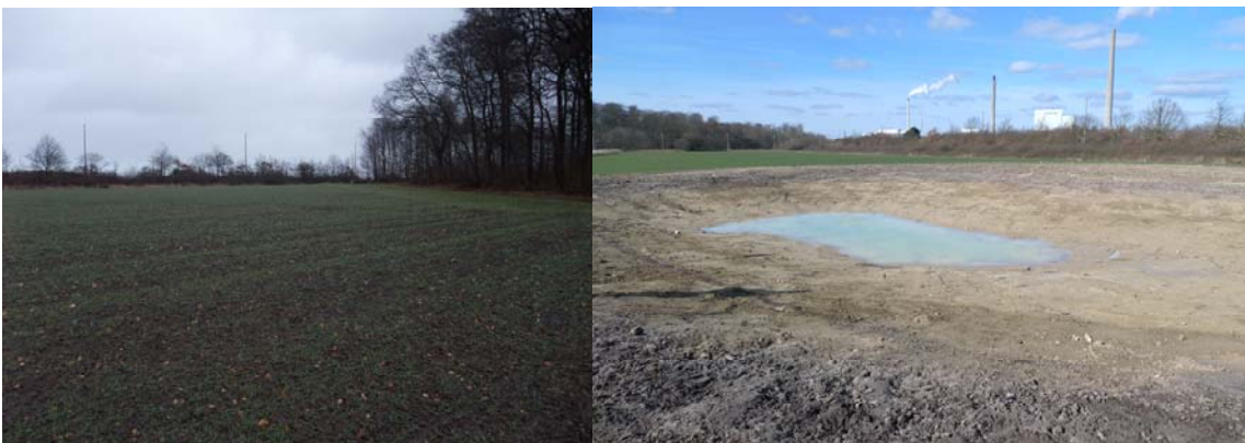
Vandhul 8 før gravning (venstre) og kort efter gravning (højre).
